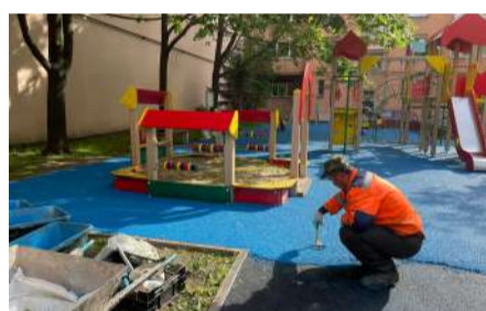
Ремонт резинового покрытия.
