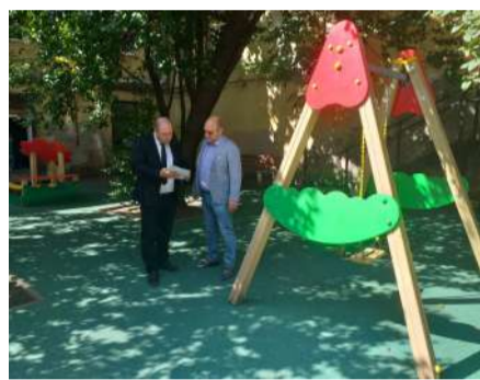
Укладка полимерного покрытия. Гончарная, 18.
