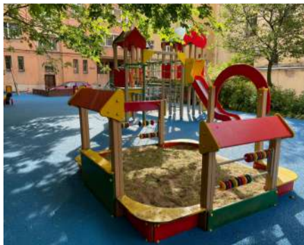
Ремонт резинового покрытия. Невский проспект, 115.
